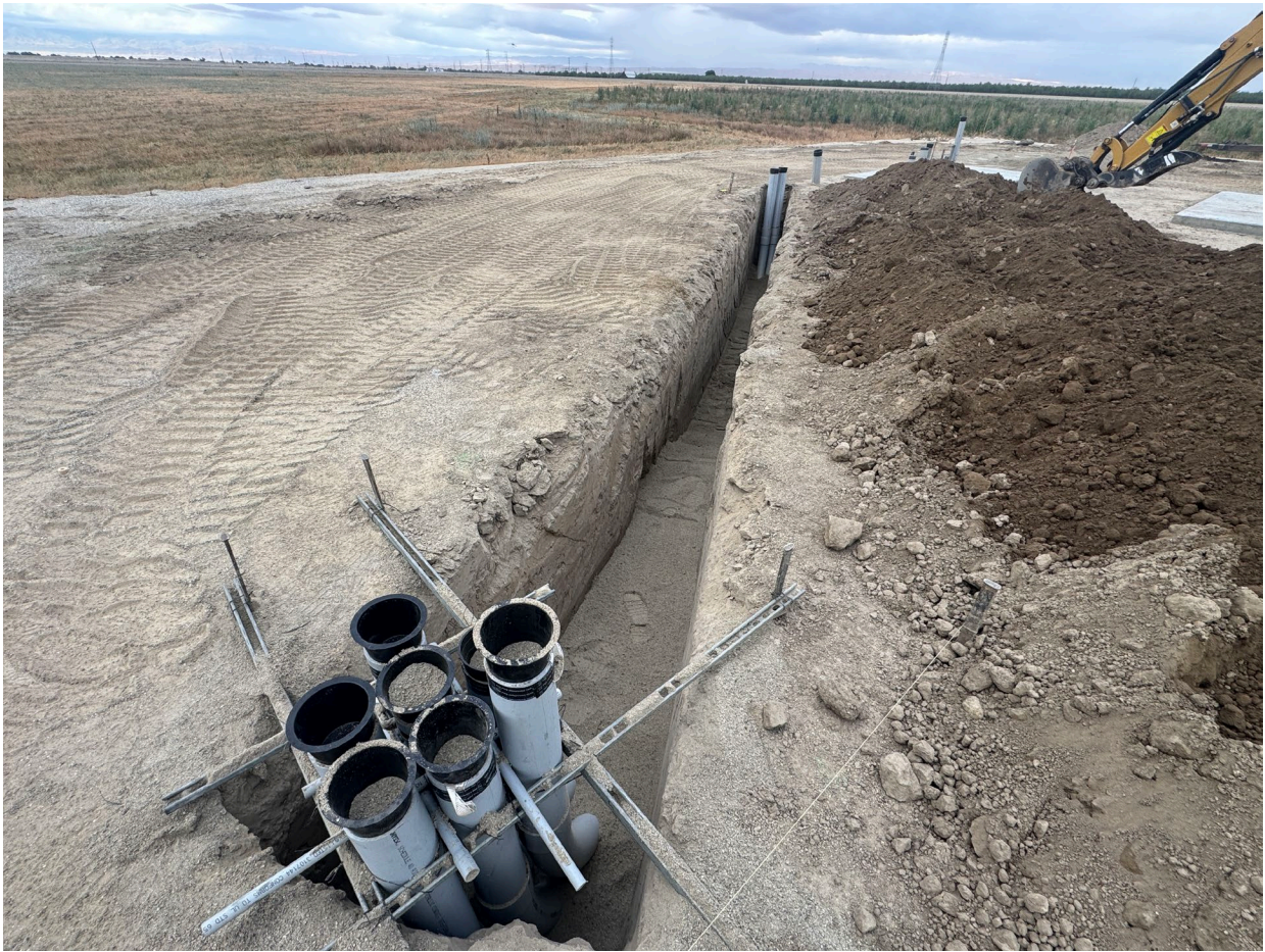
Conduit Installation for SN-1
