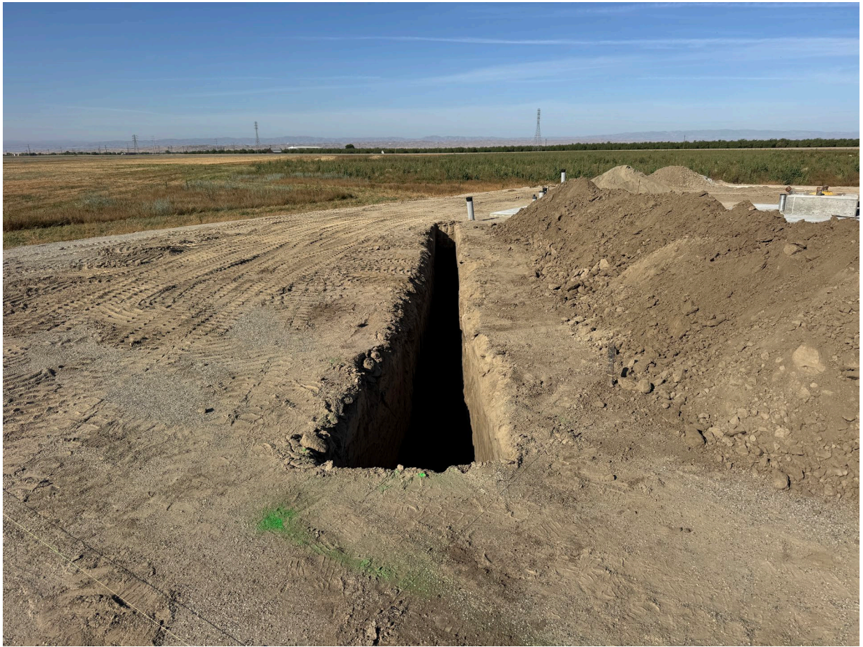
Conduit Installation for SN-1
