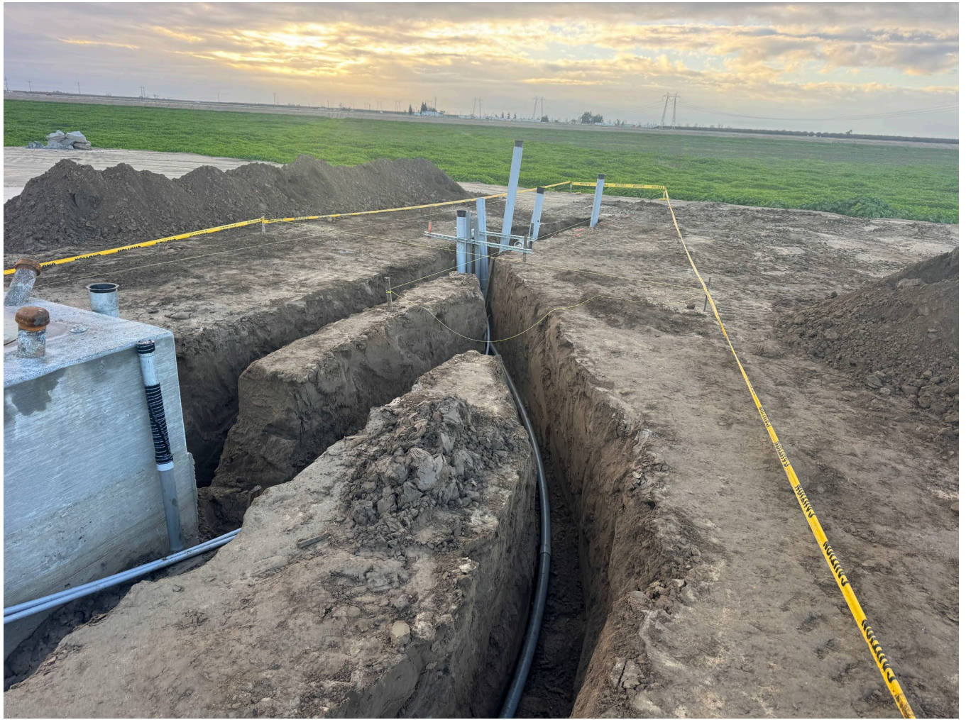
Electrical Conduit Installation
